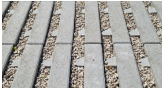
referentie: grasbetonsteen Hydro Lineo 22 met split
